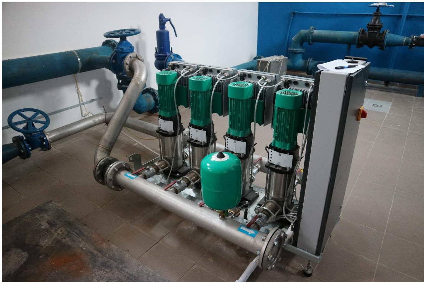
Rysunek 33. Gospodarka wodno-ściekowa na terenie gminy Chodel
