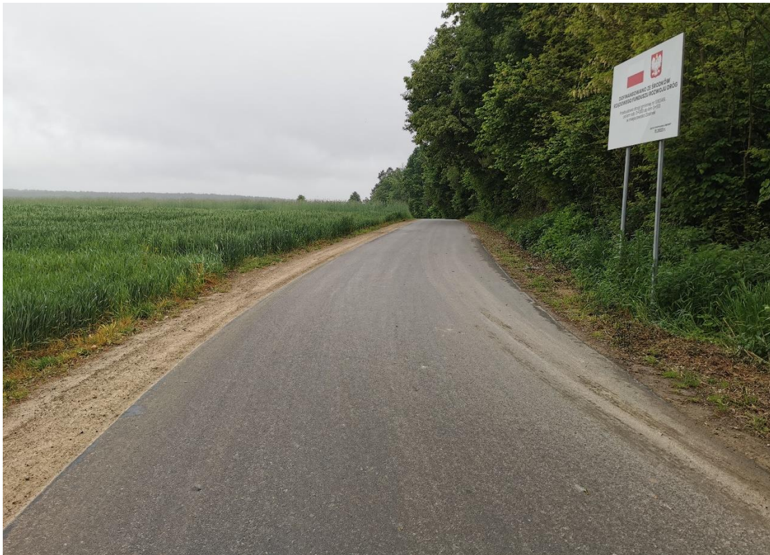
Zdjęcie 3 Przebudowa drogi gminnej nr 108246L w m. Zosinek
