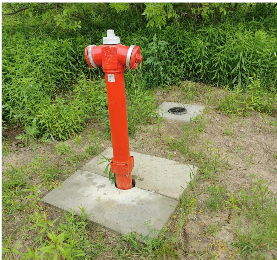
Zdjęcie 7 Rozbudowa sieci wodociągowej w m. Chodel i m. Przytyki
