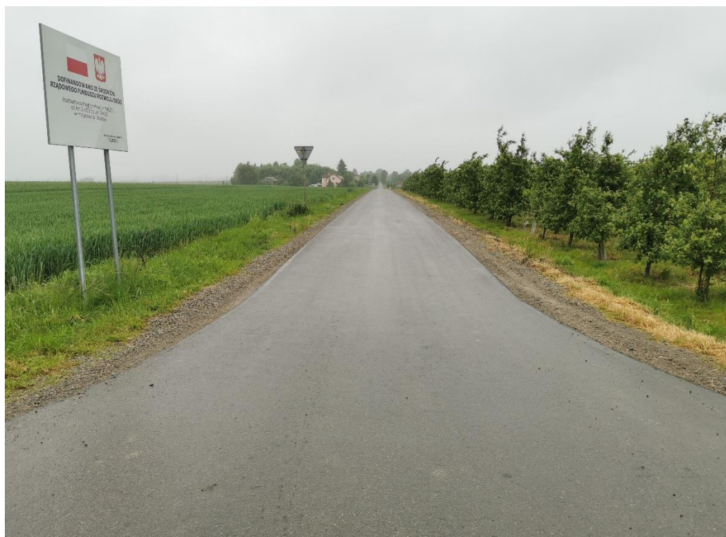
Zdjęcie 2 Przebudowa drogi gminnej nr 108251L w m. Godów
