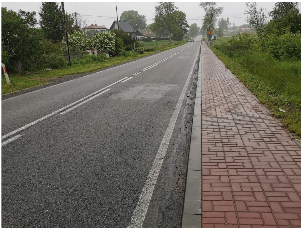
Zdjęcie 1 Budowa chodnika w m. Przytyki
