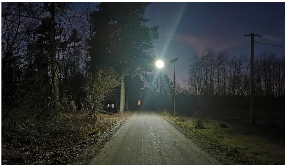
Zdjęcie 8 Montaż latarni w m. Książ i m. Osiny
