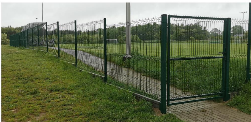
Zdjęcie 9 Modernizacja boiska do piłki nożnej w m. Chodel – wykonanie ogrodzenia, monitoring
