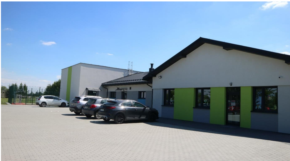
Zdjęcie 4 Budowa przedszkola i świetlicy szkolnej przy Szkole Podstawowej w Granicach
